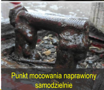
Wspornik skorodowany na wylot
